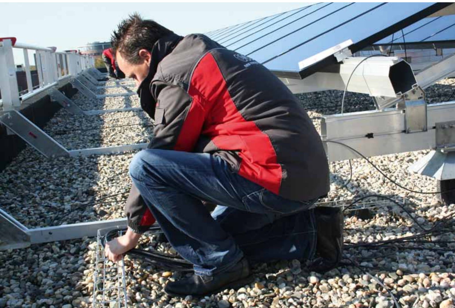
Conduct Technical Solutions breidt haar activiteiten op het dak van de gebouwde omgeving in ons land uit, zoals hier op het gemeentehuis van Oss.
